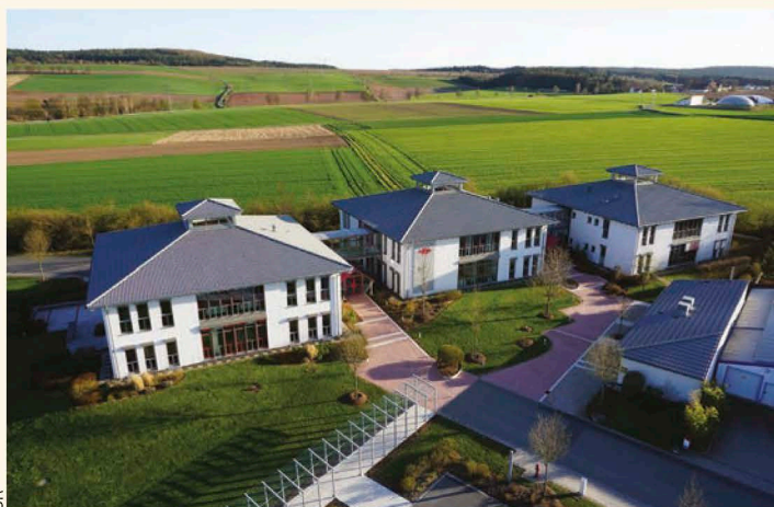
La société AKW Equipment+Process Design est implantée à Hirschau, au nord de la Bavière, à moins de 100 km de la République tchèque. Cette région d'Allemagne est connue pour ses exploitations de kaolin dont l'une a été reconvertie en parc d'attraction.
