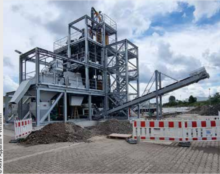
© AKW Apparate + Verfahren
