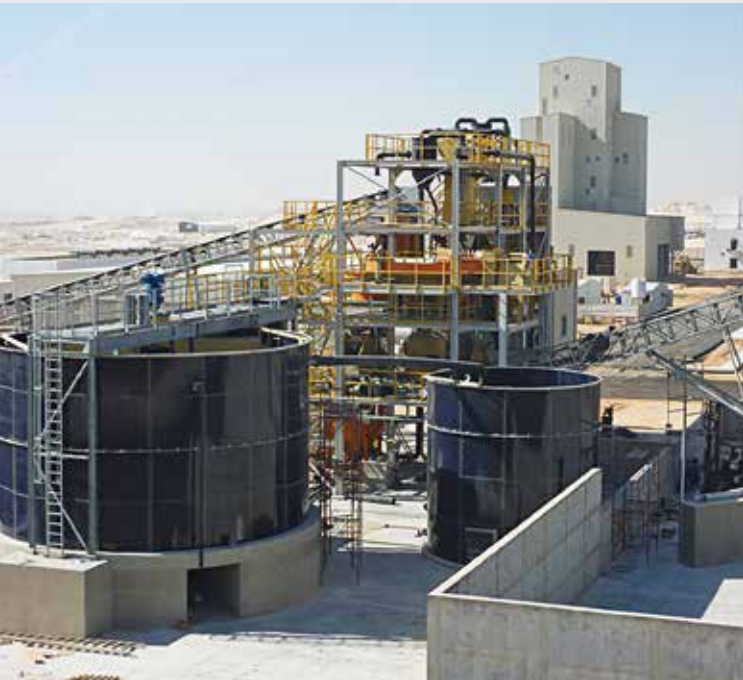
© AKW Apparate + Verfahren
